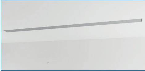
Positionieren Sie die selbstklebende Schneideschablone an der gewünschten Stelle an Ihrer Abhangdecke. Prüfen Sie vorher falls es bereits Öffnungen in der Abhangdecke gibt ob es evtl. an der gewünschte Montagestelle Hindernisse gibt, wie z.Bsp. Rohr-, Lüftungs- oder Elektroleitungen.
